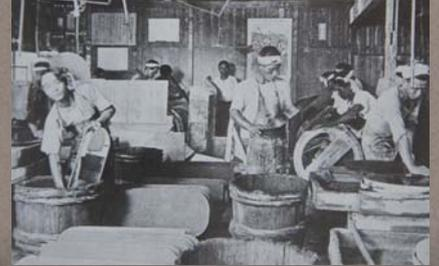
回転円板に鏡の縁をあてて摺りおろした後、回転砥石で鏡面を仕上げる鏡面取り作業。
