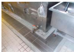
ステンレス製の蓋と排水溝
